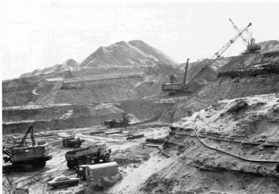
Grondwerk en eerste betonwerk Benedenhoofd. Massief en semi-massief beton: \pm 650.000 \text{ m}^3 . Grondwerken in den droge: 4,2 \text{ miljoen m}^3 . Baggerwerken: 4,5 \text{ miljoen m}^3 .
