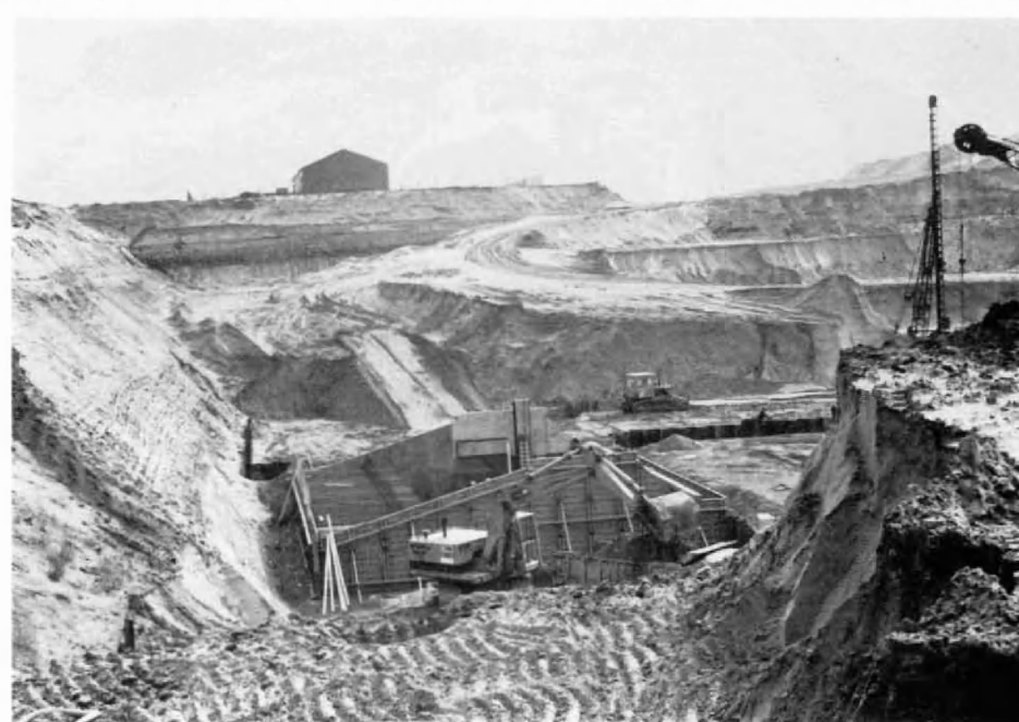
Grondwerk en eerste betonwerk Benedenhoofd. Massief en semi-massief beton: \pm 650.000 \text{ m}^3 . Grondwerken in den droge: 4,2 \text{ miljoen m}^3 . Baggerwerken: 4,5 \text{ miljoen m}^3 .
