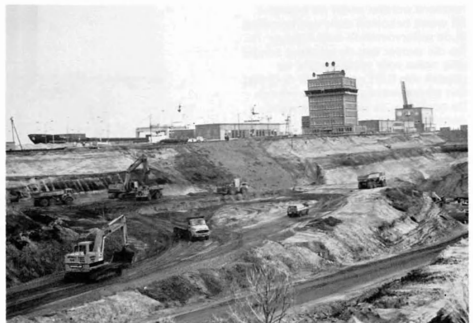
Uitgraven en eerste betonwerk Benedenhoofd, merk het bestaande controlegebouw op van de Zandvlietluis (uitvoerig beschreven in het Excavatornummer van augustus 1963).
