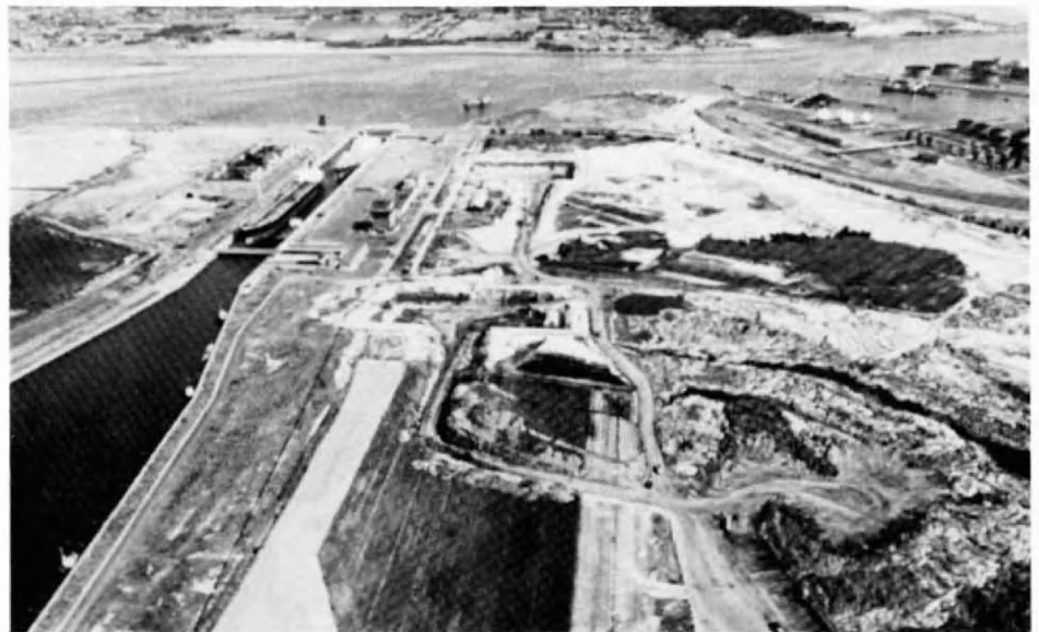
A gauche, l'actuelle écluse de Zandvliet. Au centre et à droite, les travaux d'excavation pour l'écluse de Berendrecht.
