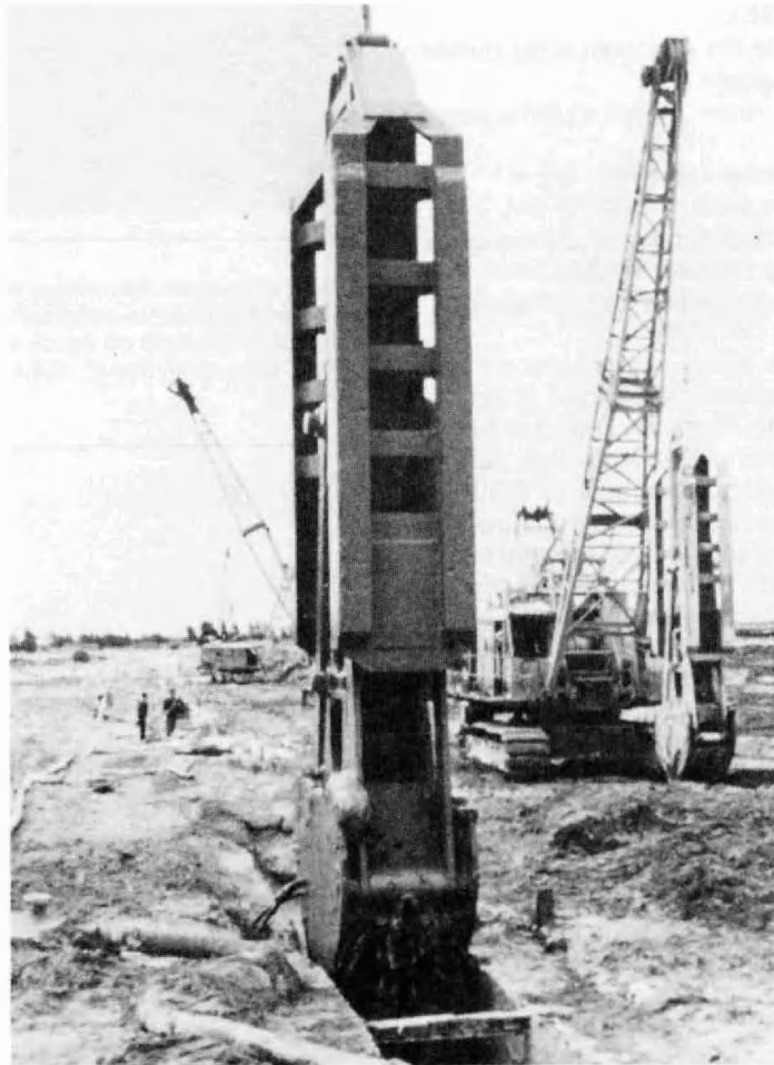
De Kelly-grijper graaft de sleuf.
