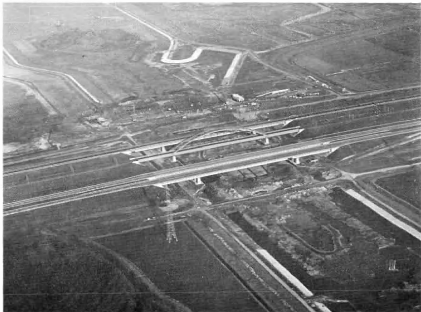
Der Brückenkomplex beim Kreekrakdamm.
