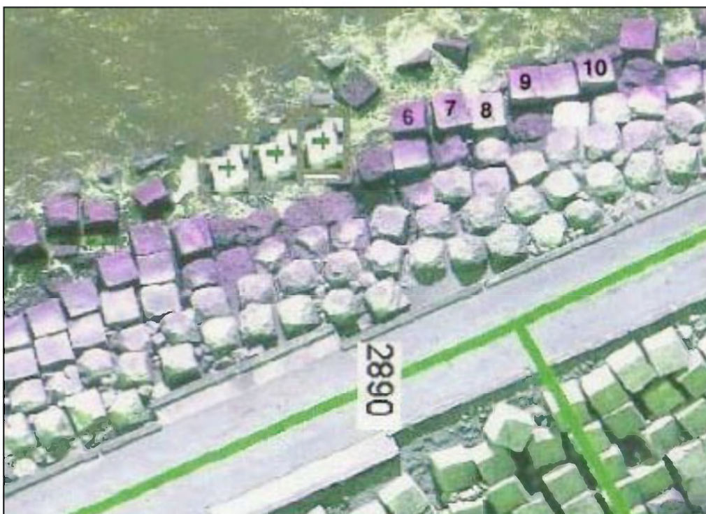
Foto 2. Ligging (oude) blokken 6 t/m 10. Bewerking luchtfoto RWS/TDN Emmen. Er zijn ook blokken met een + gemarkeerd. Dit zijn blokken, die kort na de bemonstering op 26 april zijn bijgeplaatst.
