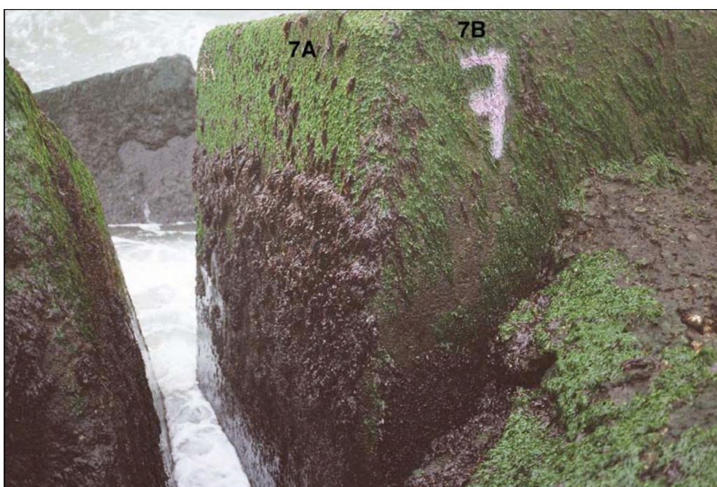
Foto 060426#012. Blok 7, vlak 3 (A op foto) en 2 (B op foto).
