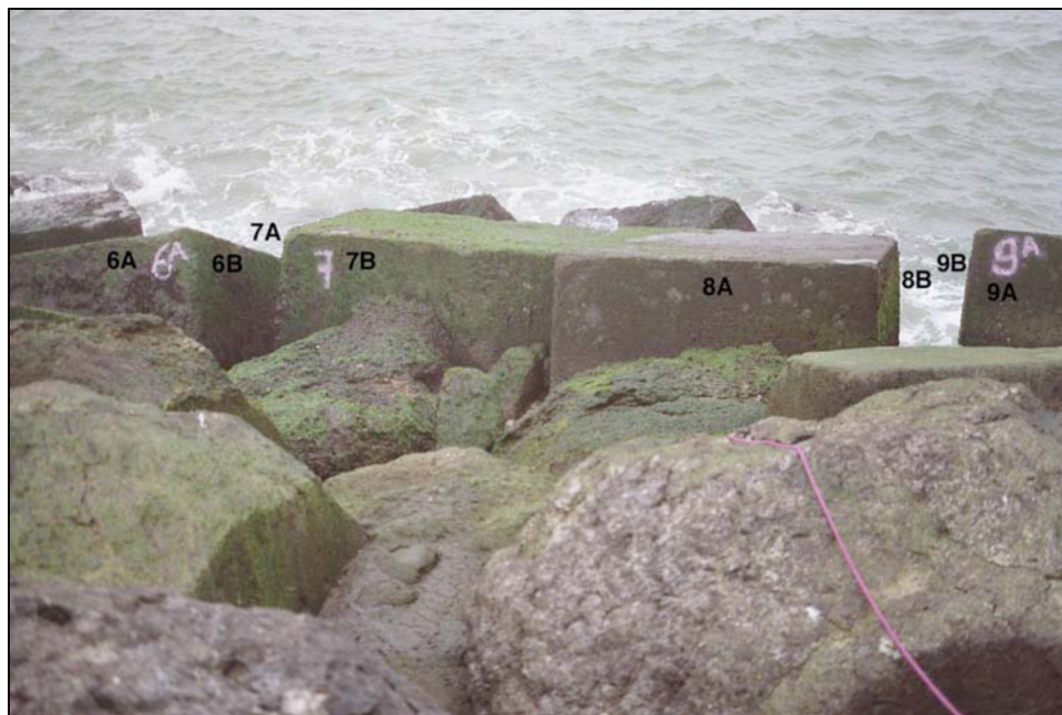
Foto 060426#010. Overzicht blokken 6, 7, 8 en 9.
