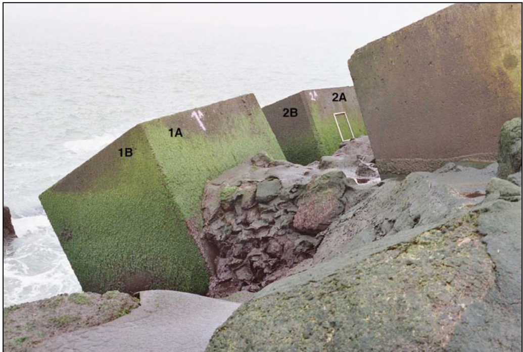
Foto 060426#002. Blokken 1 en 2. Blokken 3, 4 en 5 liggen in het vervolg van blok 2.
