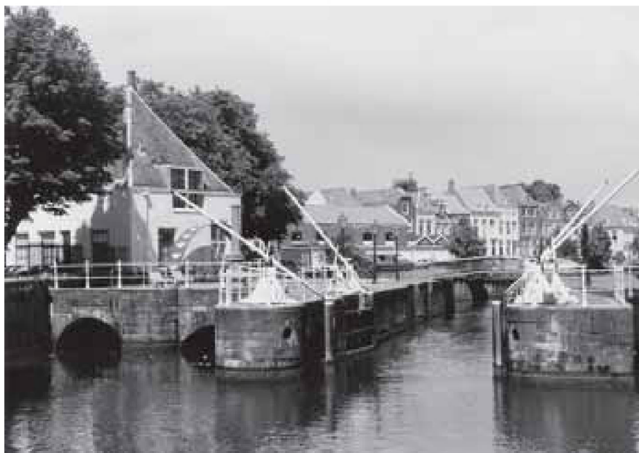
Afb. 8. Het gerestaureerde complex, gezien vanaf de Vlissingsebrug (landzijde). Het gebouw links is de voormalige getijmolen, rechts de schutsluis. Duidelijk is het maalgat (uiterst links) en de spuisluis (midden) te zien. Foto: W.Th. van der Veur.
