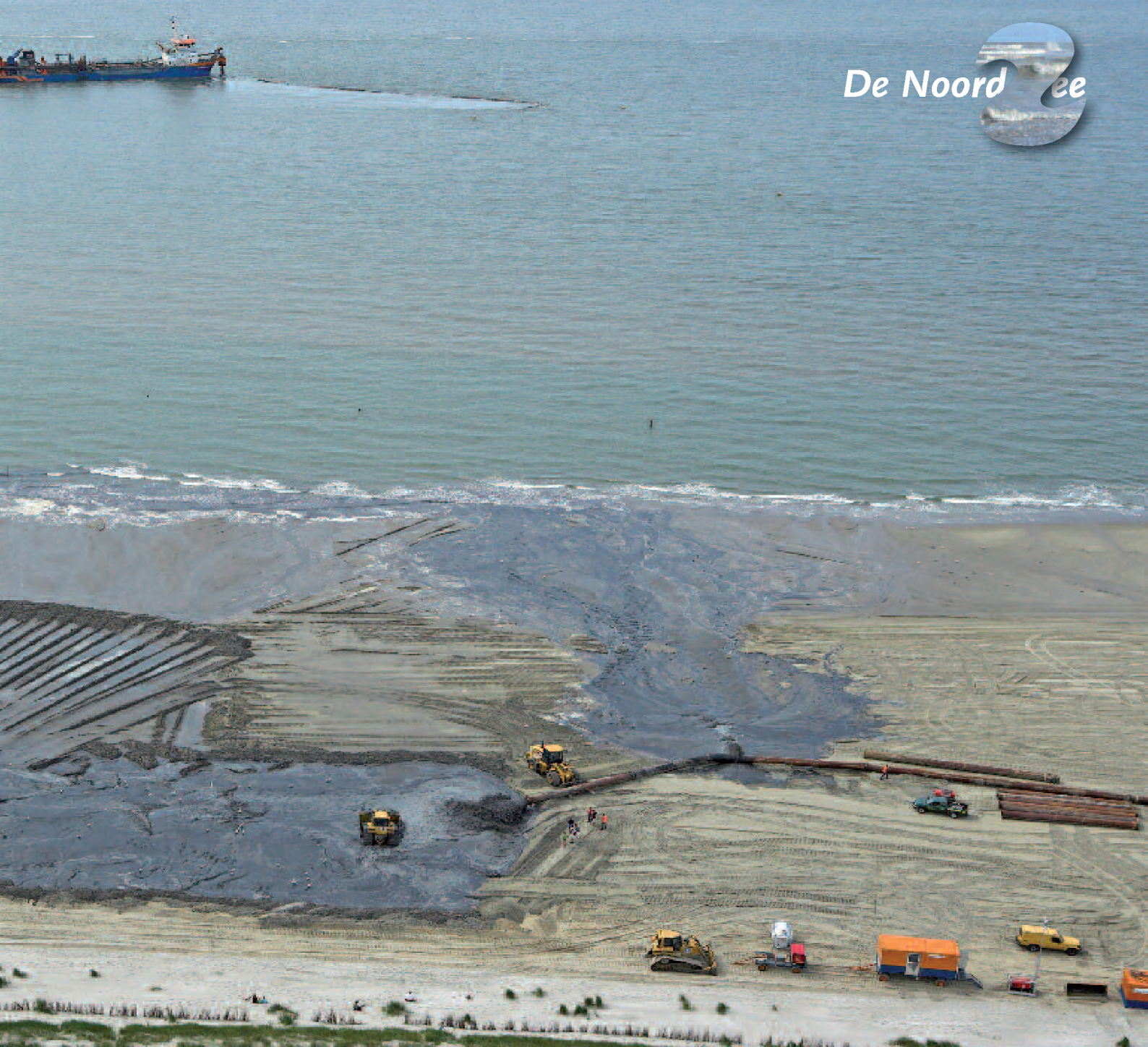
Foto 1. Strandsuppletie Zeeland 2008 (foto: RWS-kustlijnzorg).
