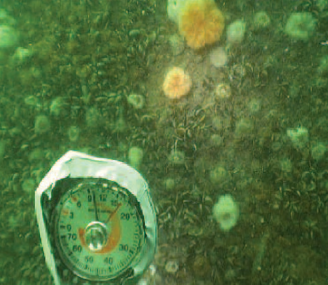
Foto 3. Aangroei op een windturbine op tien meter diepte (bron: Bouma & Lengkeek, 2009; video opname Wals diving bv).
