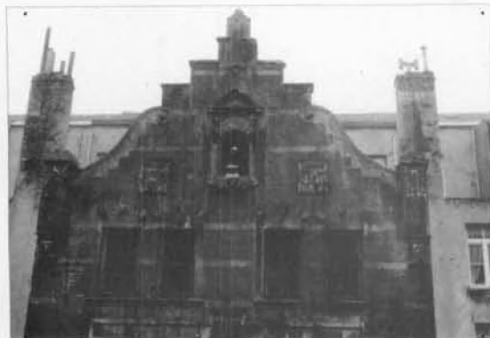
Een zicht op het bovengedeelte van de gevel
