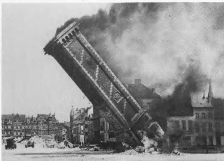
Het laatste torentje wordt opgeblazen aan de zijde van de Perronstraat (1956). Einde van station 1 en 2.
