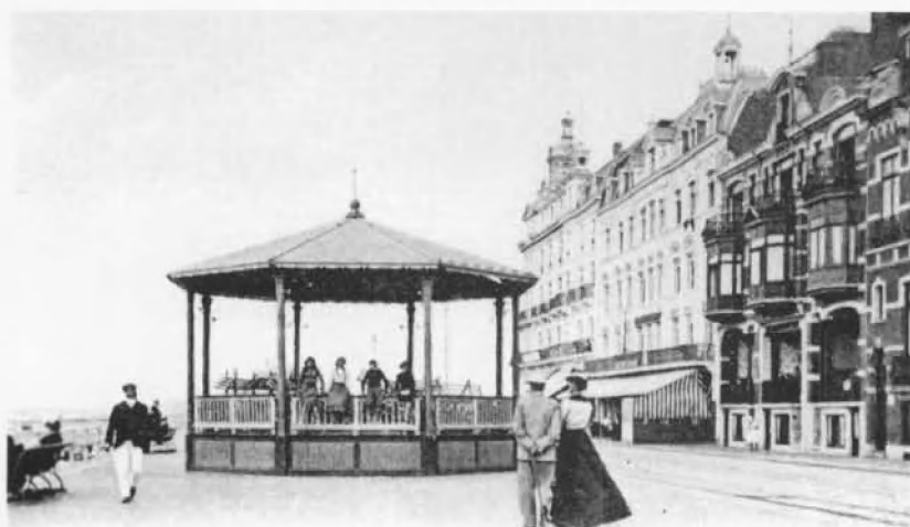
Digue de Mer
