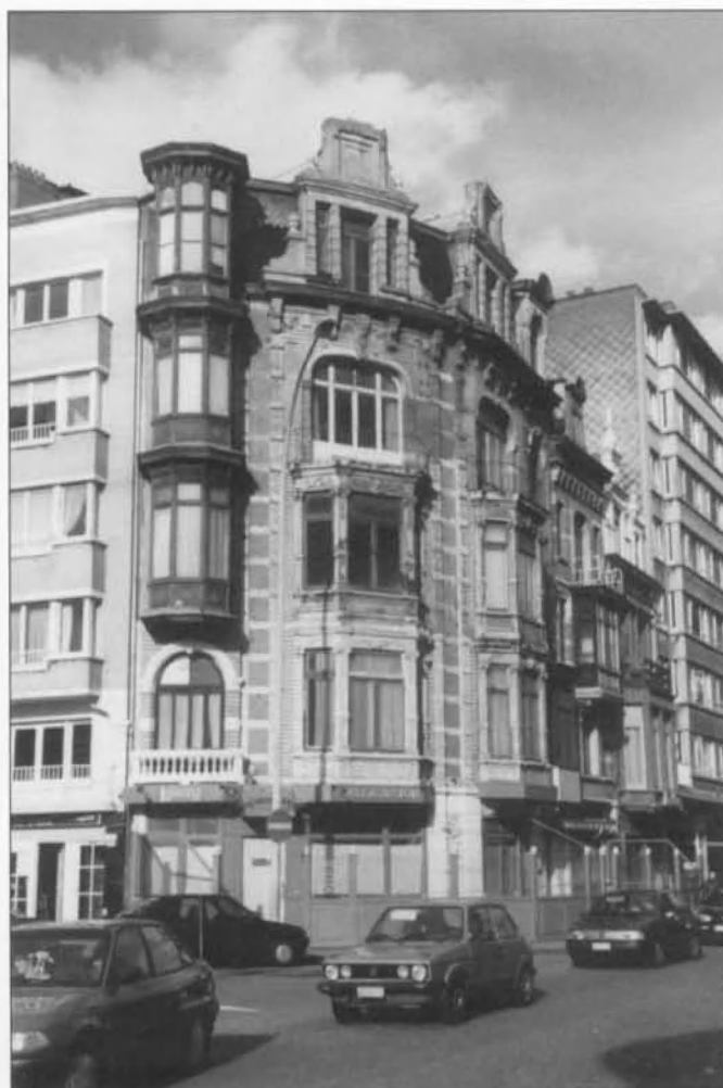
Voor de restauratie Foto's: Wille - Joosten.
