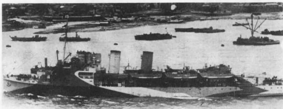
H.M.S. Prince Leopold in een haven in de Middellandse zee, 1943. Bemerkt de opbouw op het stuurhuis, de "monkey bridge".
