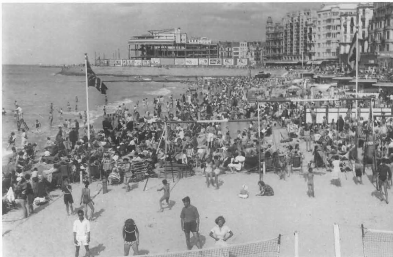
Het Kursaal in opbouw
