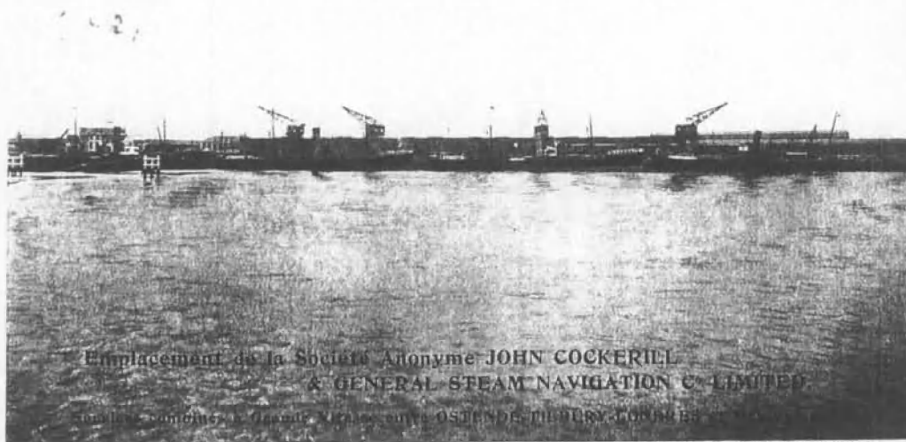
Zicht op de diepwaterkaai (Cockerillkaai) ca. 1912. We bemerken de drie schepen van de Cockerillvoet : Saphir, Topaze en Rubis en rechts één schip van de General Steam. De kaai is uitgerust met een grote hangaar en vier elektrische kranen
