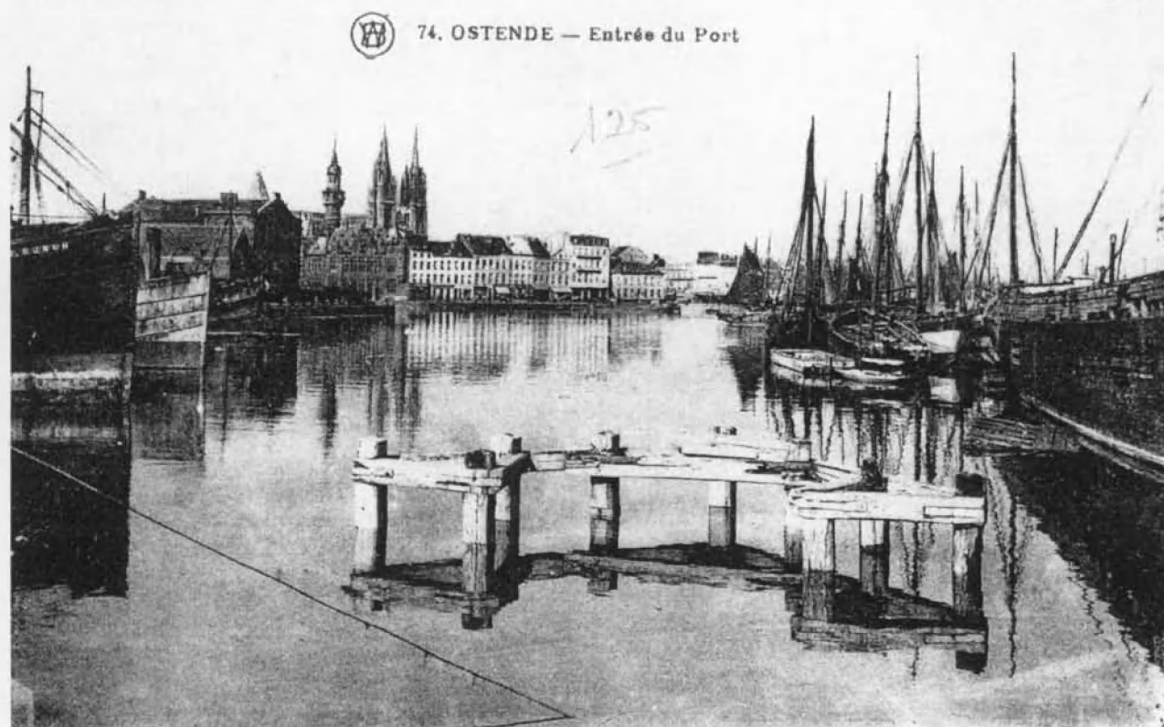
Het Brandarisdok na de afbraak van de stuwbrug. Het dok staat rechtstreeks in verbinding met de handelsdokken. Links ziet men het voor de helft afgebroken openbaar stapelhuis.
