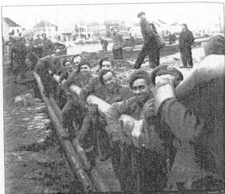
Fig. nr. 44? Haven Oostende, september/oktober 1944. Canadese geniesoldaten (Royal Canadian Engineers), bij de aanleg van de Dumbo-pijplijn op de aanlegsteiger aan het kanaal Oostende-Brugge, ter hoogte van het clubhuis van de roeivereniging RSNO (vulgo : "de Sport Nautique"). Het beginpunt van de pijplijn lag op de Diepwaterkaai (Cockerillkaai) te Oostende. In de achtergrond de Prinses Elisabethlaan te Bredene (Sas-Slijkens). Helemaal links de schouw van het visafvalverwerkingsbedrijf "Pescator", gelegen op het einde van de Prinses Elisabethlaan. (wordt aldaar "Brugscsteenweg"). Midden achtergrond, aan de Prinses Elisabethlaan, het bijhuis van de cooperatieve S.E.O. (Bijhuis Nr. 8), op de hoek van de Spaarzaamheidstraat.
