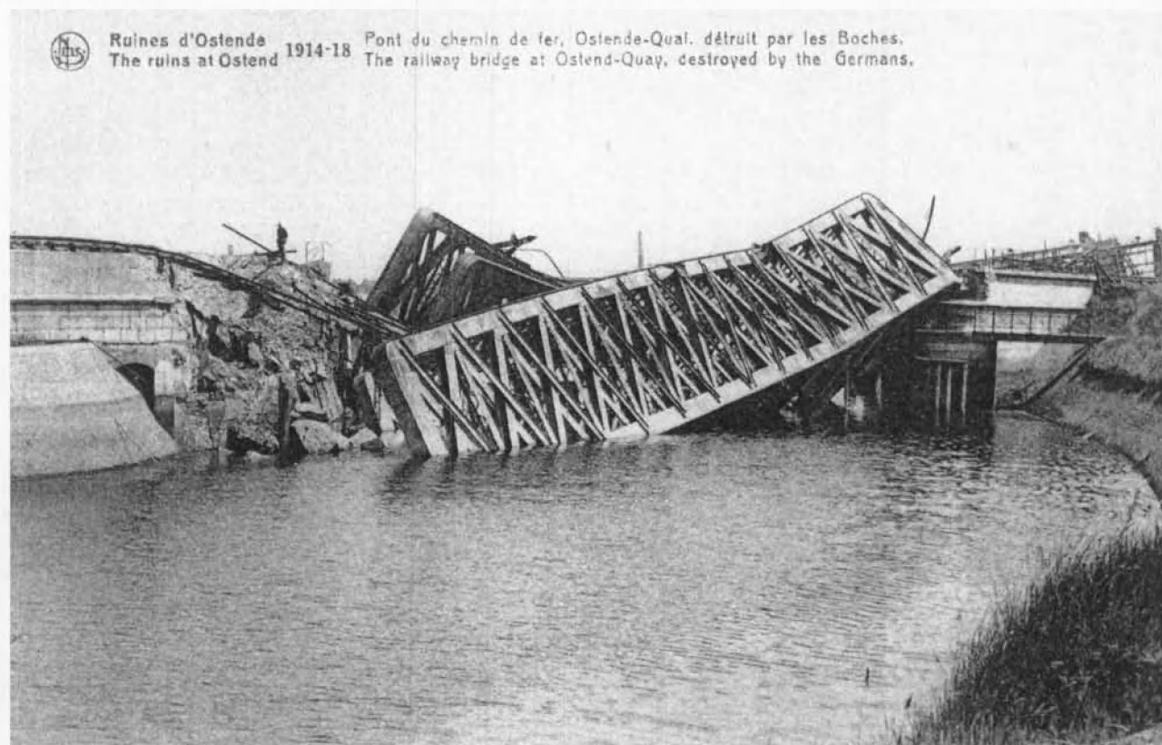
De dubbele metalen spoorwegbrug met 4 sporen, die gebouwd werd op het einde van de afleidingsvaart bij het zwaaidok, zorgde voor de rechtstreekse spoorwegverbinding naar Oostende Kaai. Ze werd bij de aftocht van het Duitse leger in oktober 1918 grondig vernield. Zicht naar het zwaaidok toe.
