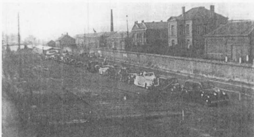
Fig. nr. 132. Haven Oostende omstreeks 1938. Op de voorgrond de aankomststeiger aan de oosteroever voor de carferry "London-Istanbul". Op de steiger een rij personenauto's die hun beurt afwachten om ingescheept te worden door een chauffeur van het Zeewezen (de auto's mochten niet door hun eigenaar in- en ontscheept worden, dit mocht wel ná W.O. 2).
