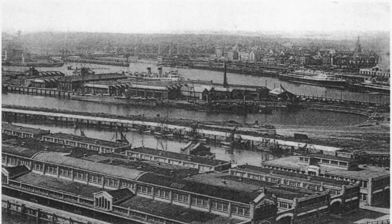
Fig. nr. 130. Haven Oostende, omstreeks 1936. Midden de werkhuizen van het Zeewezen. Op de voorgrond de toen nieuwe vismijn. Bemerkt aan de Pakketbotenkaai de toen nieuwe (eerste) dieselpakketboot m.s. "Prince Baudouin". Aan de kaai van de Scheepsbouwdienst een stoomturbinepakketboot van de "Prins"-klasse.
