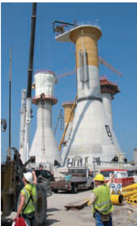
■ De betonnen gravitaire fundering ("Gravity Based Foundation" – GBF) is vandaag toegepast bij zowat 25% van de in Europese zeeën geplaatste turbines. Het systeem is wat op zijn retour o.a. vanwege de lange bouwtijd en de transport- en installatieproblemen eigen aan deze zware constructies (BV)
