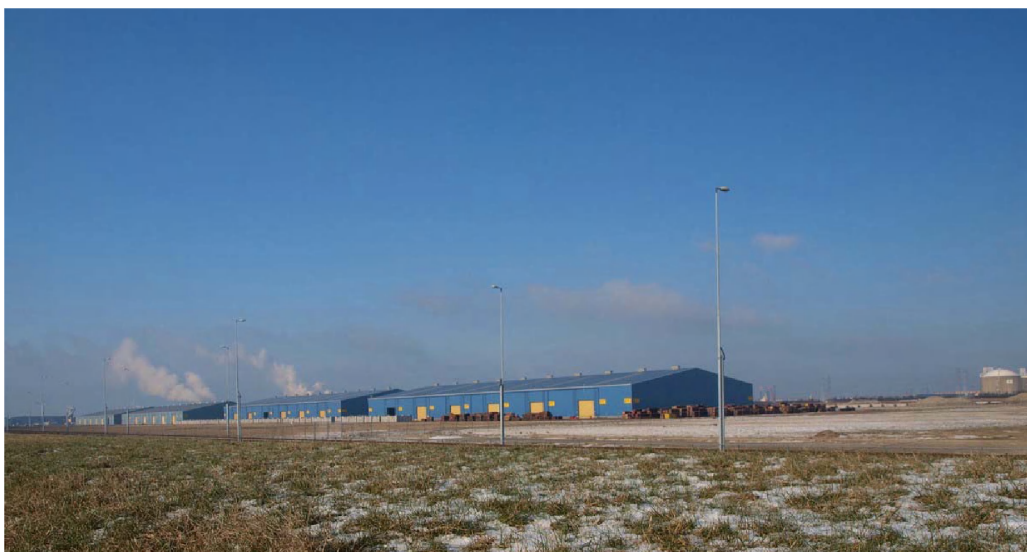
figuur 7.5 Bestaande terminal van Verbrugge aan de Scaldiahaven
