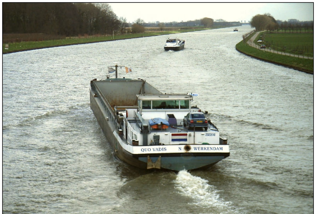
Amsterdam-Rijnkanaal ter hoogte van Houten
