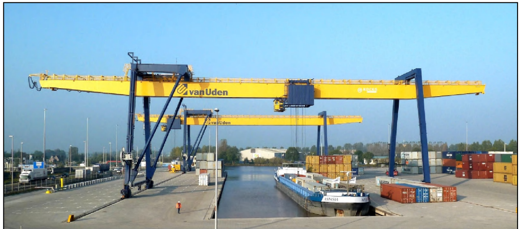
Containerterminal Alphen aan de Rijn, geopend 1 oktober 2010
