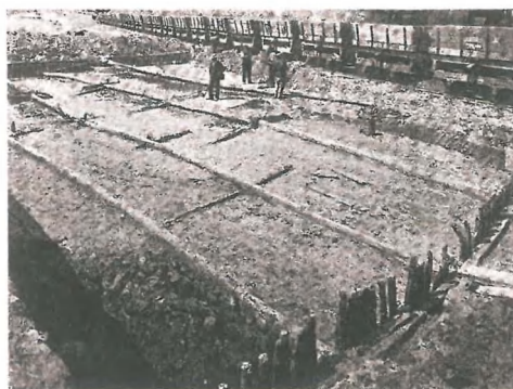
Houtconstructie van zoutpanne van Zeebrugge [Foto: Brugge, Gillès de Pélichy, 1905]
