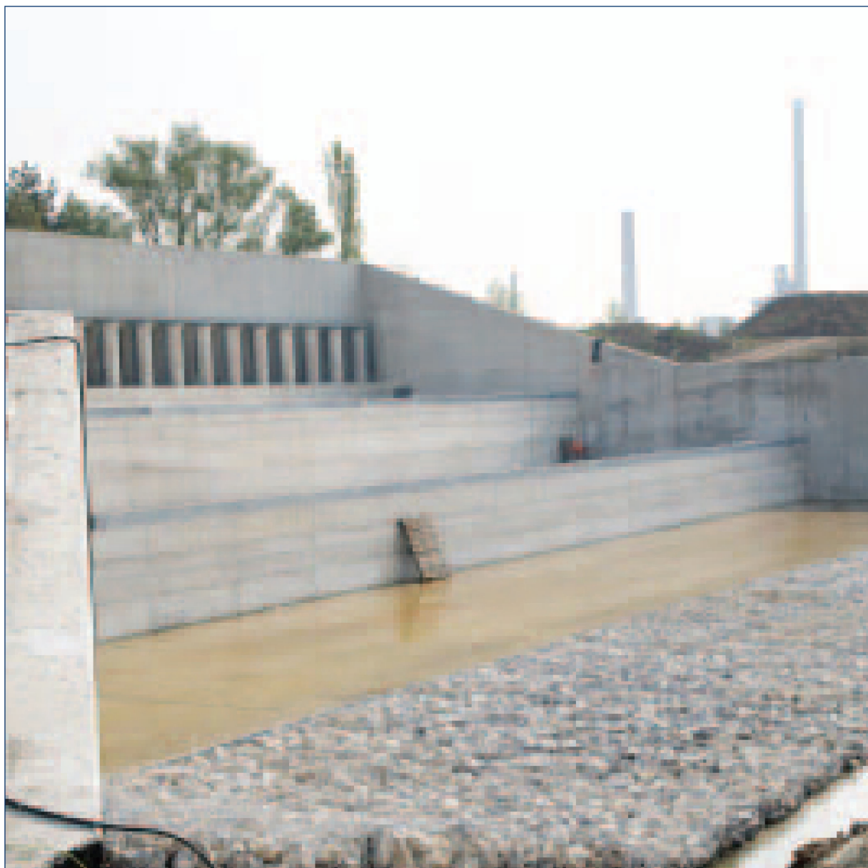
Uitwateringssluis gecontroleerd overstromingsgebied Kruibeke-Bazel-Rupelmonde
