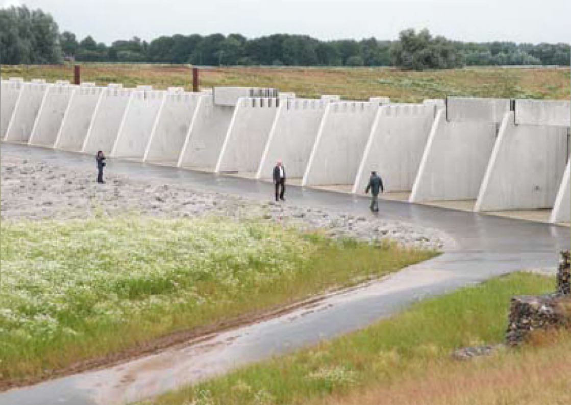
Hondsbroeksche Pleij, regelwerk in de hoogwatergeul.
