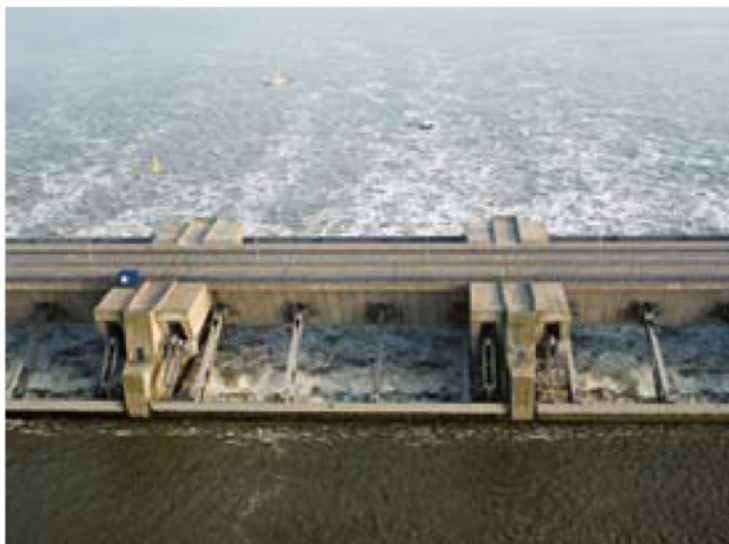
Spuisluizen in de Haringvlietdam, samen met de sluiscomplexen in de Afsluitdijk en bij IJmuiden én de stuw bij Driel, belangrijk voor het reguleren van de afvoer en de verdeling van zoet water.
