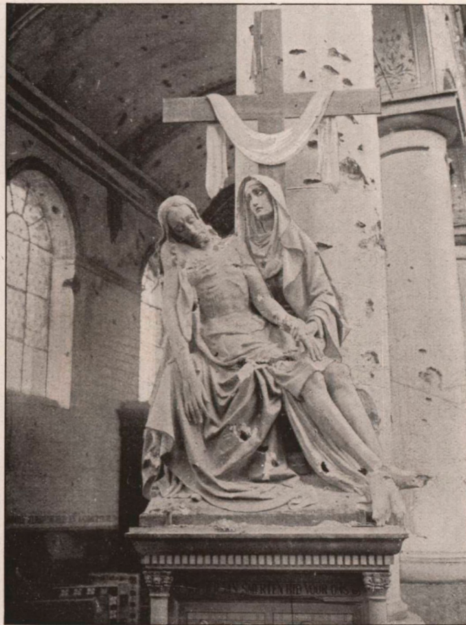
Die unzerstörte Vieta in der Kirche zu Boelcapelle.
