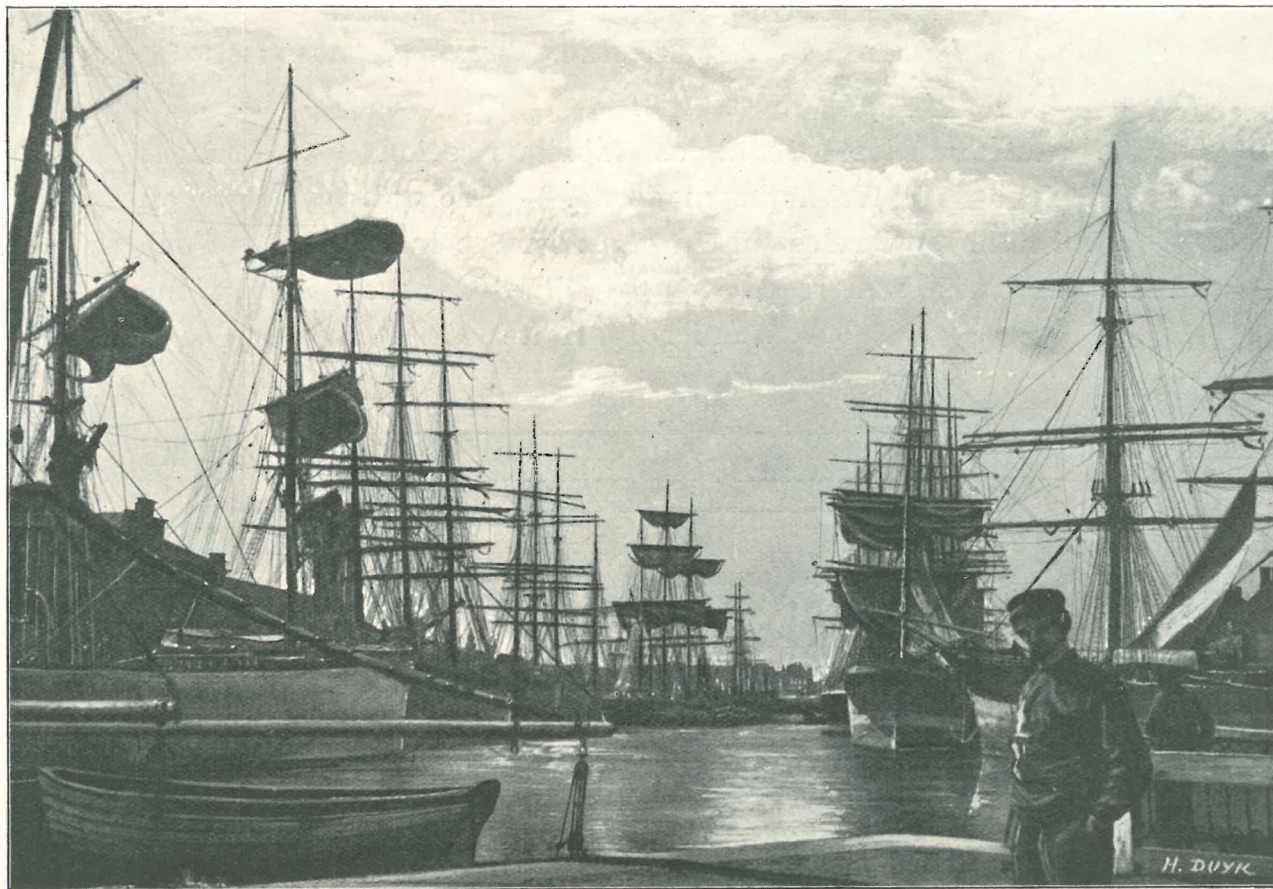
Bassin de Commerce au temps des nitrates.
