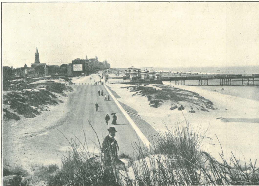
Les dunes au bout de la digue.
