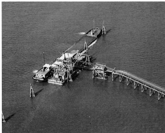
Walpersinstallatie zoals tot \pm 10 jaar geleden algemeen gebruikt werd. Met de bakkenzuiger 'Warche', bouwjaar 1961. Totaal vermogen 2.300 kW.
