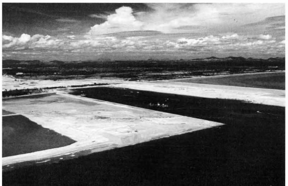
Fig. 5: Bouw van de haven van Laem Chabang door landwinning in zee en uitbaggeren van toegangseulen en dokken. In de achtergrond de cutterzuiger van het Vlaamse Baggerbedrijf Dredging International aan het werk.
