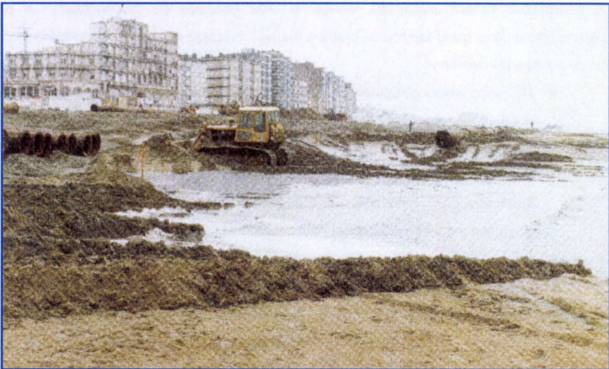
Figuur 9. Strandsuppletie in Knokke-Zoute
