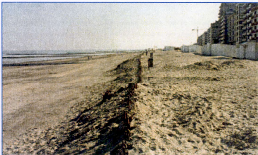
Figuur 15. Aantasting van droogstrandberm (expliciete erosieklif) in sectie 51, Knokke-Zoute tijdens storm van 29 augustus 1996 (AWZ - Waterwegen Kust [1], 1996)
