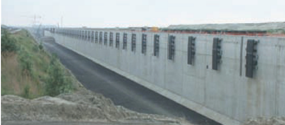
■ Zicht op een stuk van de 5,3 km lange kaaimuur van het Deurganckdok in aanbouw. De muren zijn 30 m hoog. De zwarte 'asfaltweg' helemaal onderaan is de erosiebescherming aan de teen van de kaaimuur. De zwarte platen op de muur zijn de fenders ( http://upload.wikimedia.org/wikipedia/commons/5/58/Kaaien_deurganckdok.jpg )
