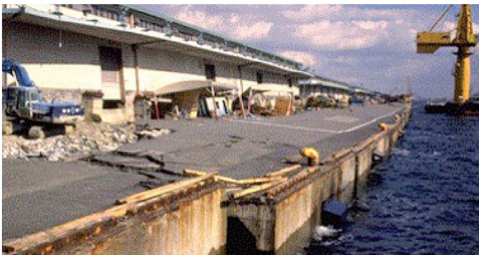
■ Een caisson kaaimuur die gekanteld is. Dit verhindert minstens tijdelijk alle havenactiviteiten op het kaaiterrein, met alle economische verliezen tot gevolg ( http://research.eerc.berkeley.edu/projects/GEER/GEER_Post%20EQ%20Reports/Kobe_1995/ch3-2.html )
