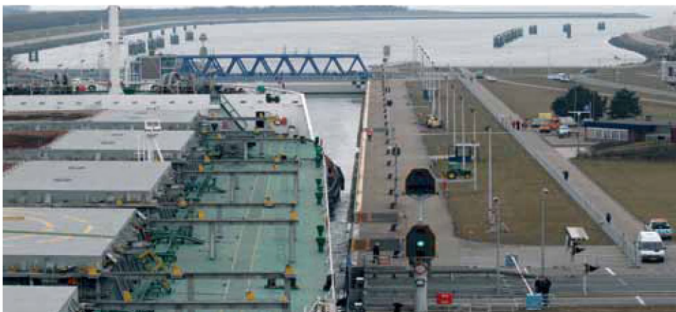
De Eptalofos in de sluis.
