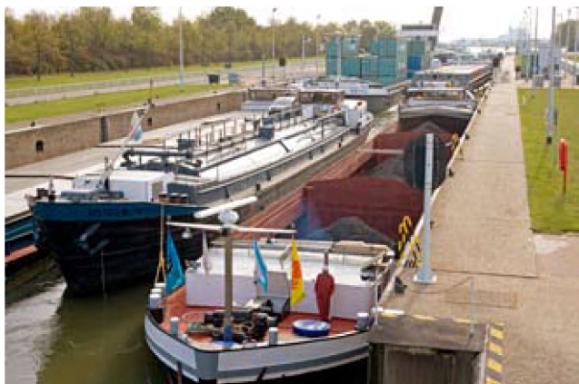
Opstellen van de sluis
