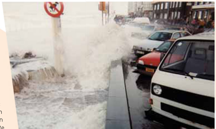
* Het probleem: Overslaande golven aan de zeedijk, vóór een zandsuppletie.
