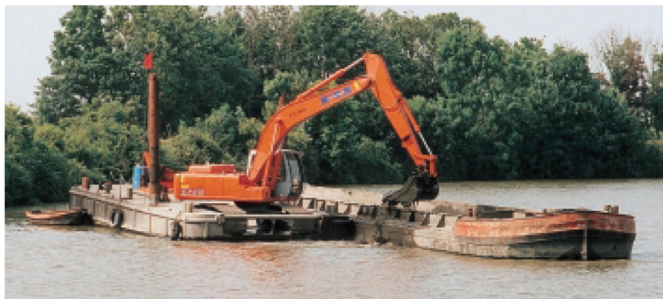
In de kleinere havens nemen baggeraars hun toevlucht tot grijpkranen die vanop pontons opereren en de specie in klepbakken dumpen. Hier een analoge werkwijze gedemonstreerd op de Uzer (WWK)
