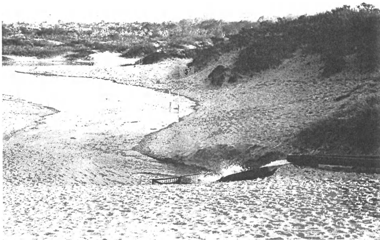
Figuur 5.1'. Herinfiltratie van grondwater dat werd opgepompt bij de aanleg van riolen (AMINAL 1992).
