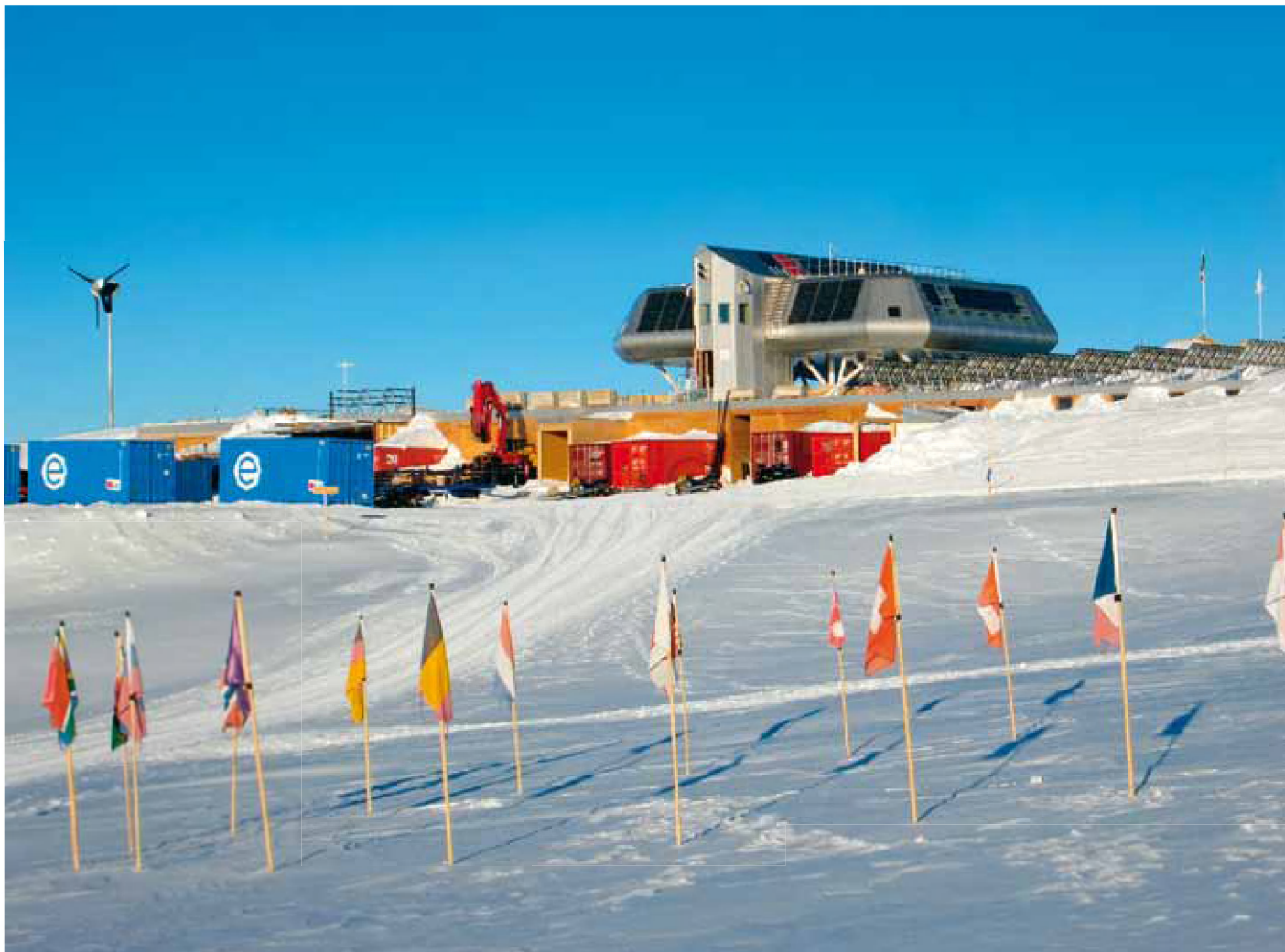
Princess Elisabeth station met transport containers voor de ingang van de garage en workshops, ingebouwd in de sneeuw en verbonden via de verticale koker met het eigenlijke station gebouwd op Utsteinen Ridge (© Hugo Declair)
