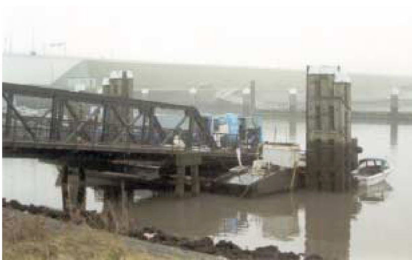
De merklocatie bij de Haringvlietsluizen, gesitueerd in de buitenhaven bij Stellendam.
