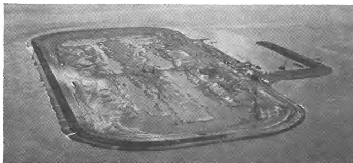
Overzicht van de bouwput
