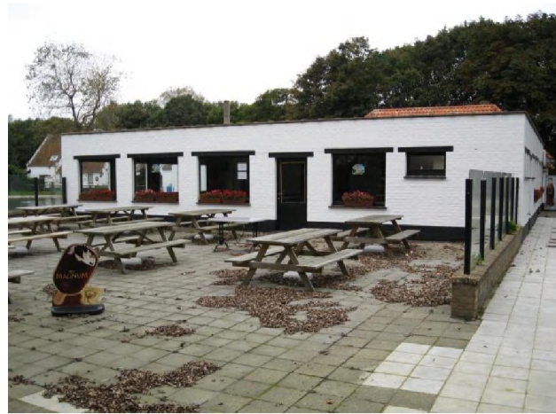
Gebouw met huidige cafetaria en pick-nick plaatsen
