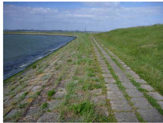
Foto 10. Buitenzijde dijk met verharding
