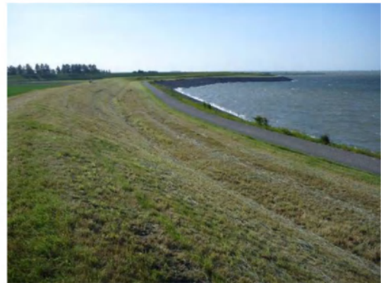
Foto 8. Pas gemaaide dijk buitenzijde
