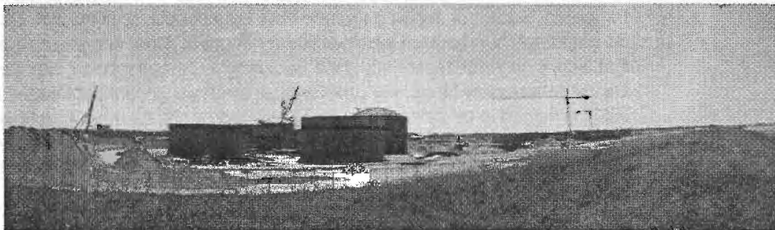
Figuur B6a.1: Bouwplaats Mosselbanken – tanks Value Park
