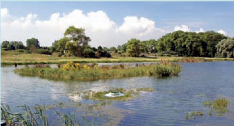
■ Zicht op het infiltratiepand van de waterwinning St-André te Koksijde. Centraal is de toevoer van water te zien. Via dit systeem wordt gezuiverd afvalwater terug in de duinen gebracht, waar het na passage door de duinzanden in opperbste toestand kan worden opgepompt en hergebruikt (AVDB)
