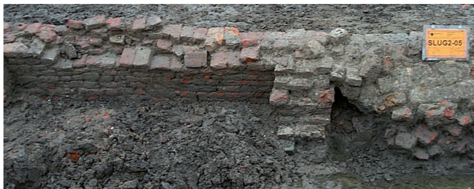
Afb. 31 Gebouw S1: oostelijke langsmuur.
