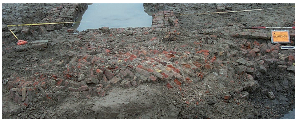
Afb. 32 Gebouw S1: het omvergevallen hogere metselwerk van de oostelijke langsmuur.
