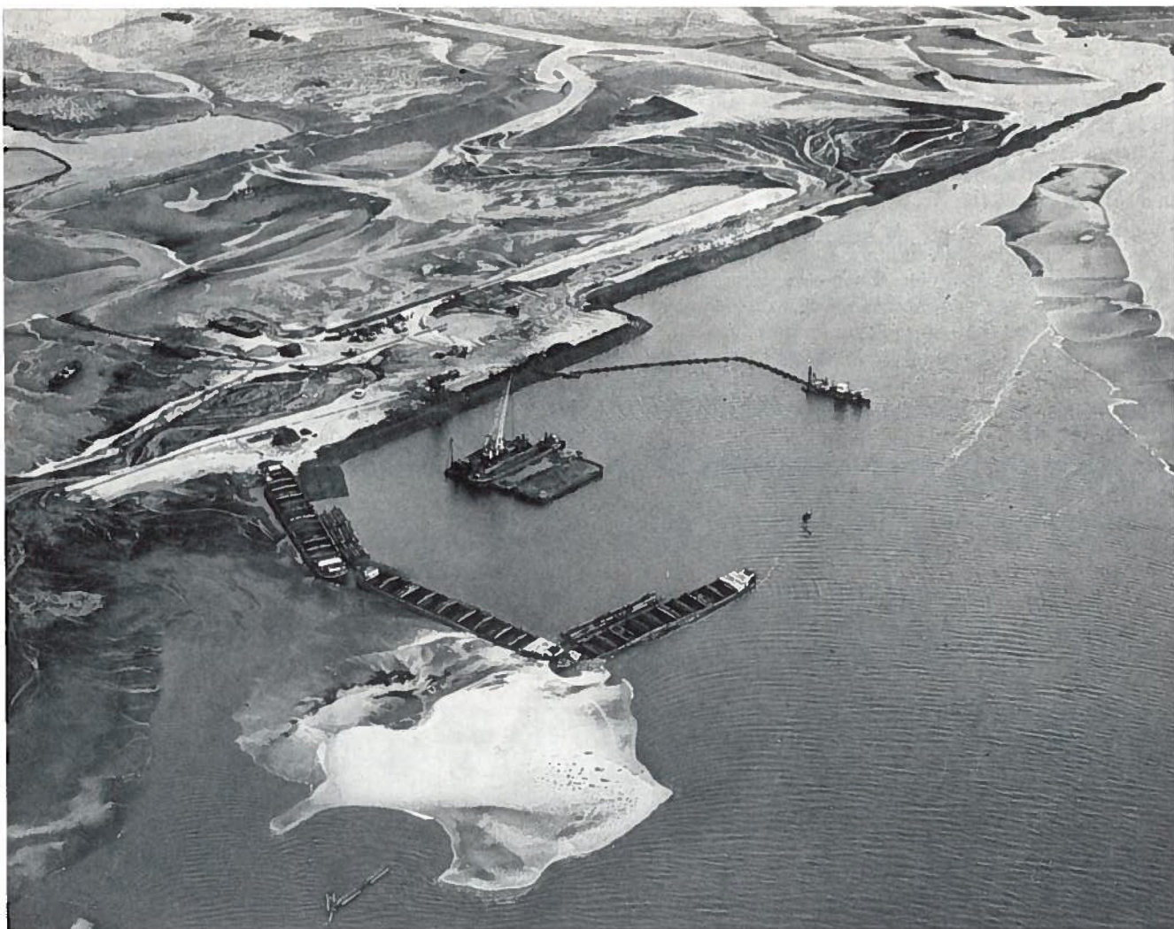
Figuur 39. Werkeiland met haven van sloopschepen, gezien vanuit het noord-westen.
