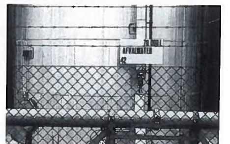
Nergens bestaat een finale „parkeerplaats” voor reststoffen.
