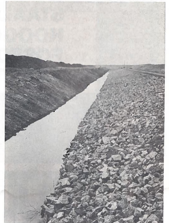
Figuur 57. Taludbestorting op kraagstuk.
