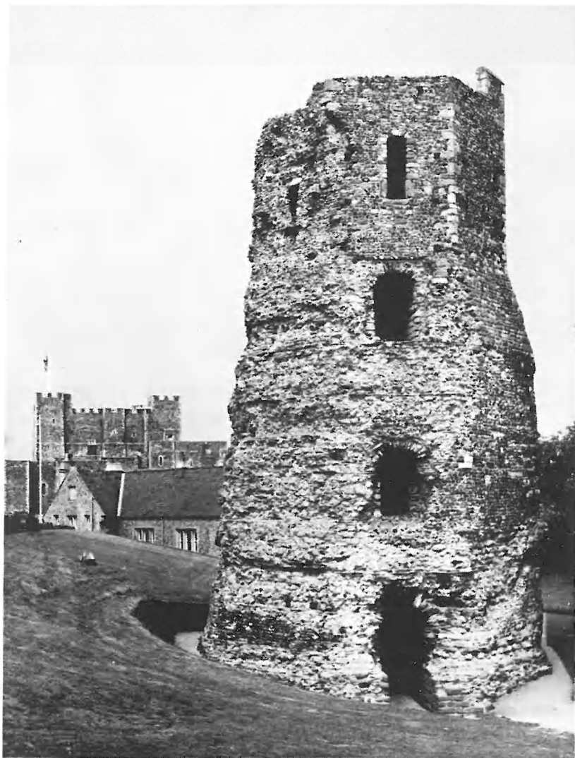
De antieke vuurtoren op Castle Hill te Dover, huidige toestand. Het achthoekige piramidale gebouw telt nog drie verdiepingen, waarvan de derde middeleeuws is, heeft een hoogte van 80 voet of ongeveer 26,5 meter en verheft zich op genoemde heuvel ongeveer 375 voet of 125 meter boven de zeespiegel. Foto: The charter trustees of the town of Dover. Clerk and treasurer: Cyril Fletcher.
