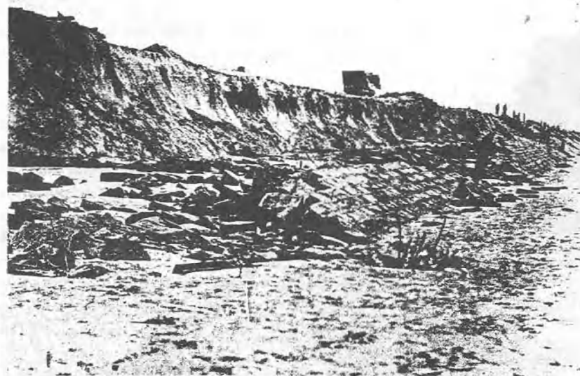
Bij een hevige storm in het najaar van 1908 werden talrijke bresen geslagen in de dijk van het Zoute.
