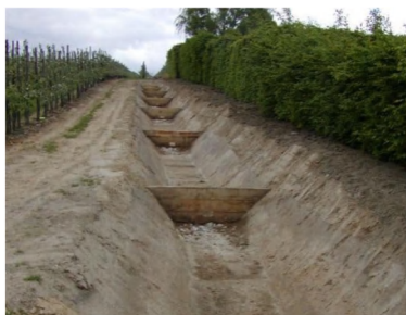
Figuur 2.8: Buffergracht met stuwconstructies
