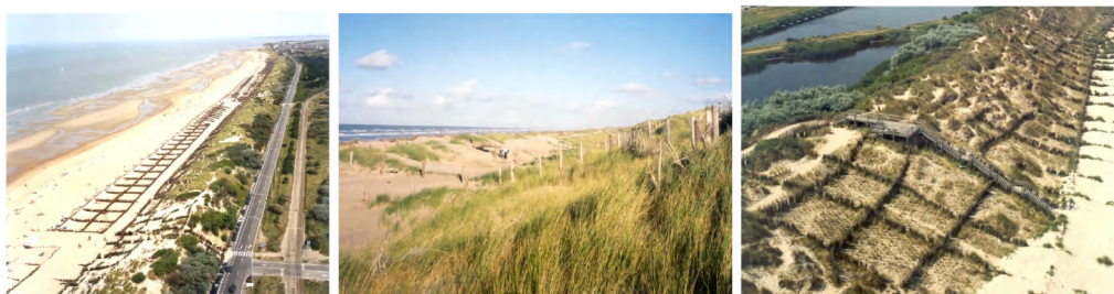
Figuur 11.7: Bevorderen van zandafzetting en verhinderen van erosie. Links: duinhagen, midden: helmgras, rechts: duinovergang om betreding te minimaliseren.
