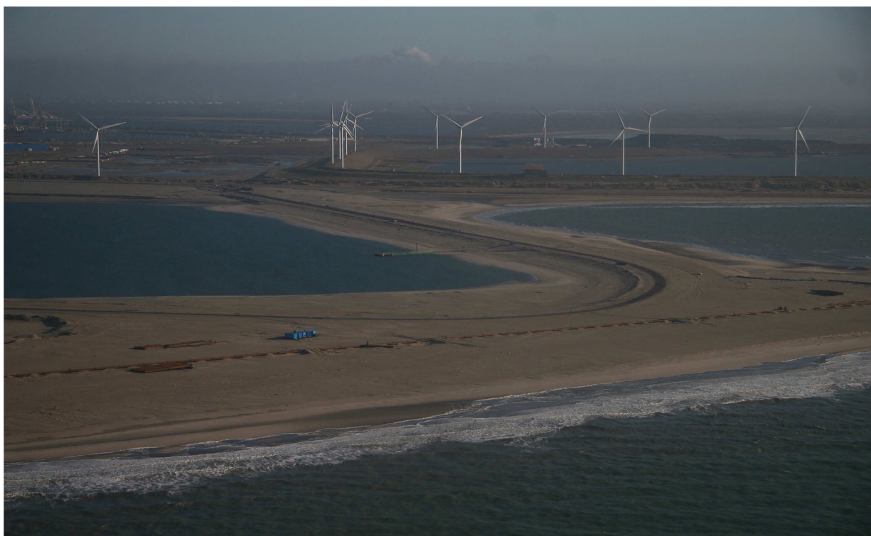
Aanleg Tweede Maasvlakte, 17 januari 2010 (foto: Pim Wolf).
