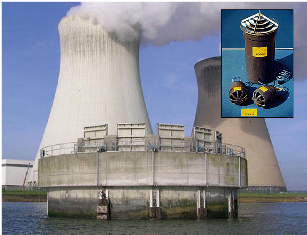
Inzuig koelwater aan de kerncentrale van Doel en voorbeeld van een luidspreker (inzet) © Ovivo
