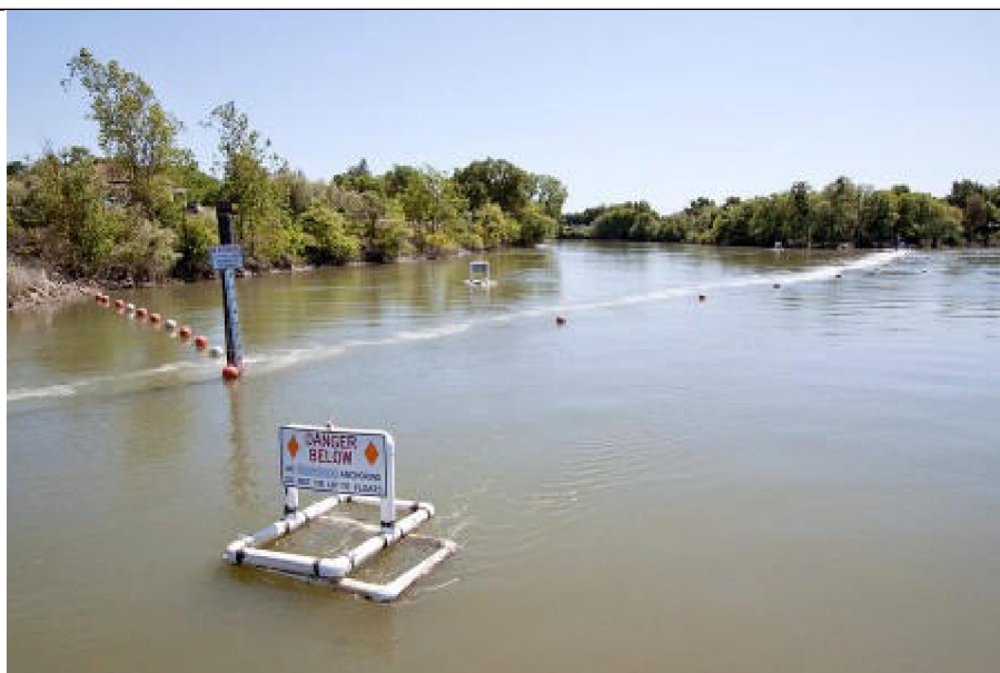
Bellengordijn (gecombineerd met strobolichten en geluid) in de San Joaquin Rivier in de VS ® FISHBIO
