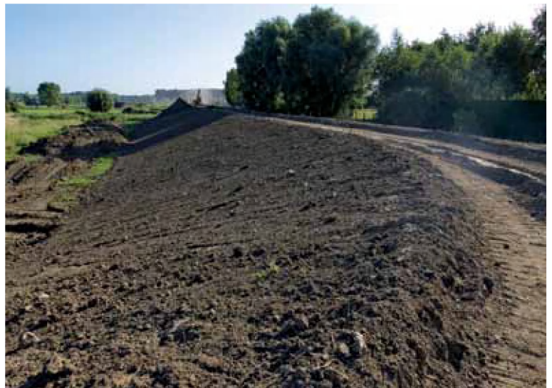
Afbeelding 7.2. Grondwerken: ophoging en verbreding van ringdijk
