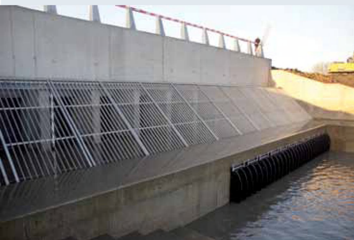
Afbeelding 7.10. Installatie van de randinfrastructuur
