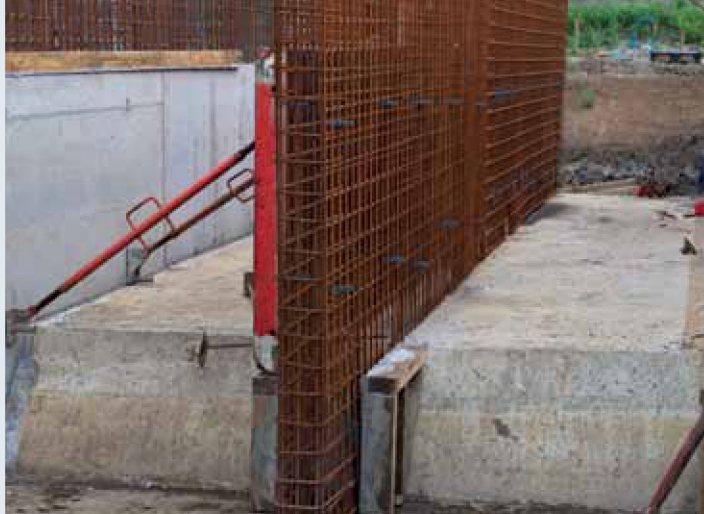
Afbeelding 7.5. Bekisting en wapening van de wanden
