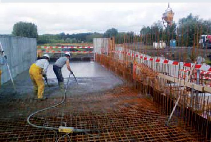
Afbeelding 7.6. Vloerplaat en damplanken tegen onderloopsheid
