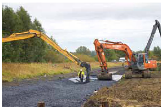
Afbeelding 712. Aanleg dissipatiegracht met open steenasfalt
