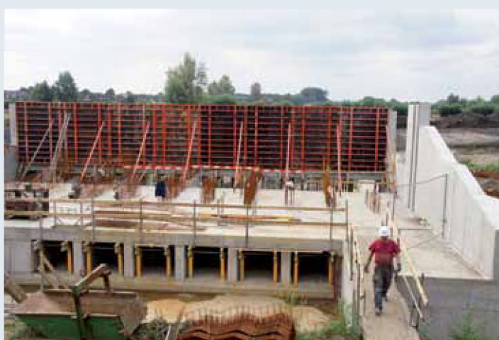
Afbeelding 7.9. Bekisting en wapening van de bovenbouw
