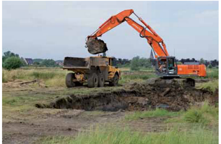
Afbeelding 7.1. Grondwerken: start uitgraven van geulaanzet
