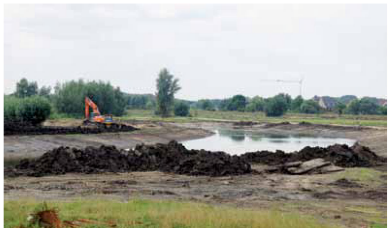
Afbeelding 7.3. Grondwerken: einde uitgraven geulaanzet
