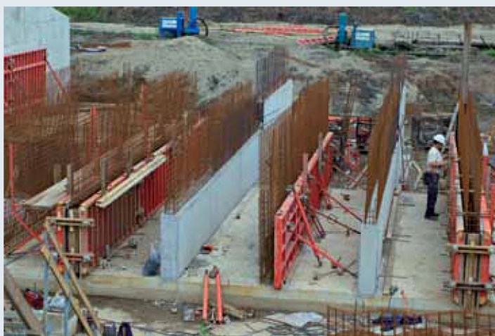
Afbeelding 7.7. Betonnering van de wanden
