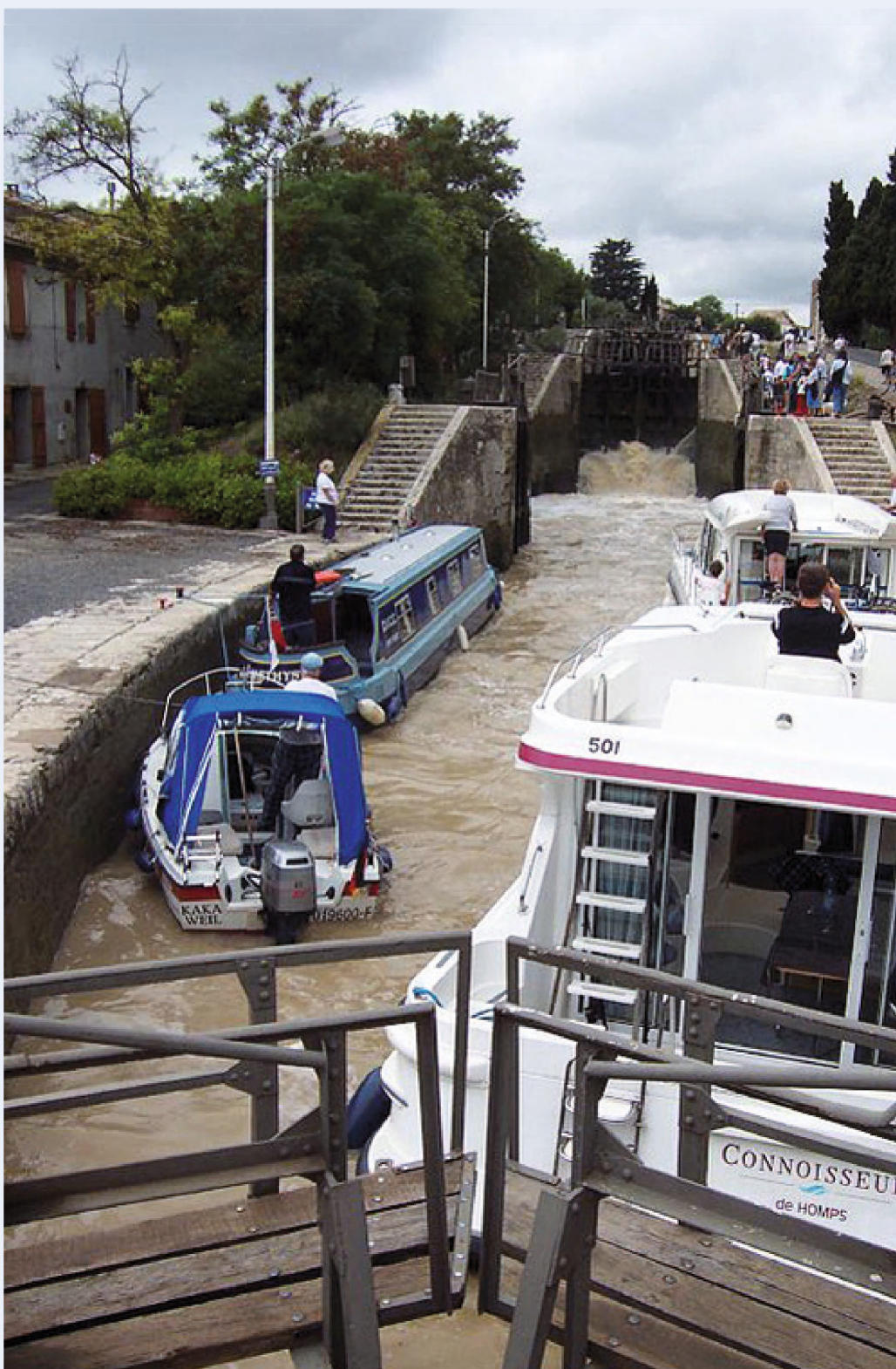
■ Een mooi voorbeeld van een reeks opeenvolgende sassens via dewelke schepen een hoogteverschil kunnen overbruggen, is te vinden ten westen van de Zuid-Franse stad Béziers. Het Fonserannes complex van 8 sluiskamers werd er tussen 1673 en 1680 gebouwd op het Canal du Midi en laat bootjes toe over nauwelijks driehonderd meter afstand, een hoogteverschil van 21,5 m te slechten (Wikimedia)
