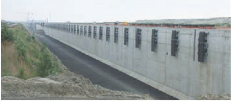
Zicht op een stuk van de 5,3 km lange kaaimuur van het Deurganckdok in aanbouw. De muren zijn 30 m hoog. De zwarte 'asfaltweg' helemaal onderaan is de erosiebescherming aan de teen van de kaaimuur. De zwarte platen op de muur zijn de fenders ( http://upload.wikimedia.org/wikipedia/commons/5/58/Kaaien_deurganckdok.jpg )
